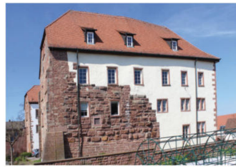
Buckelquader an der Nordseite des Schlosses Walldürn zeugen von der stauferischen Burgranlage, dem Stammsitz der Herren von Dürn. Foto: Burglandschaft.
