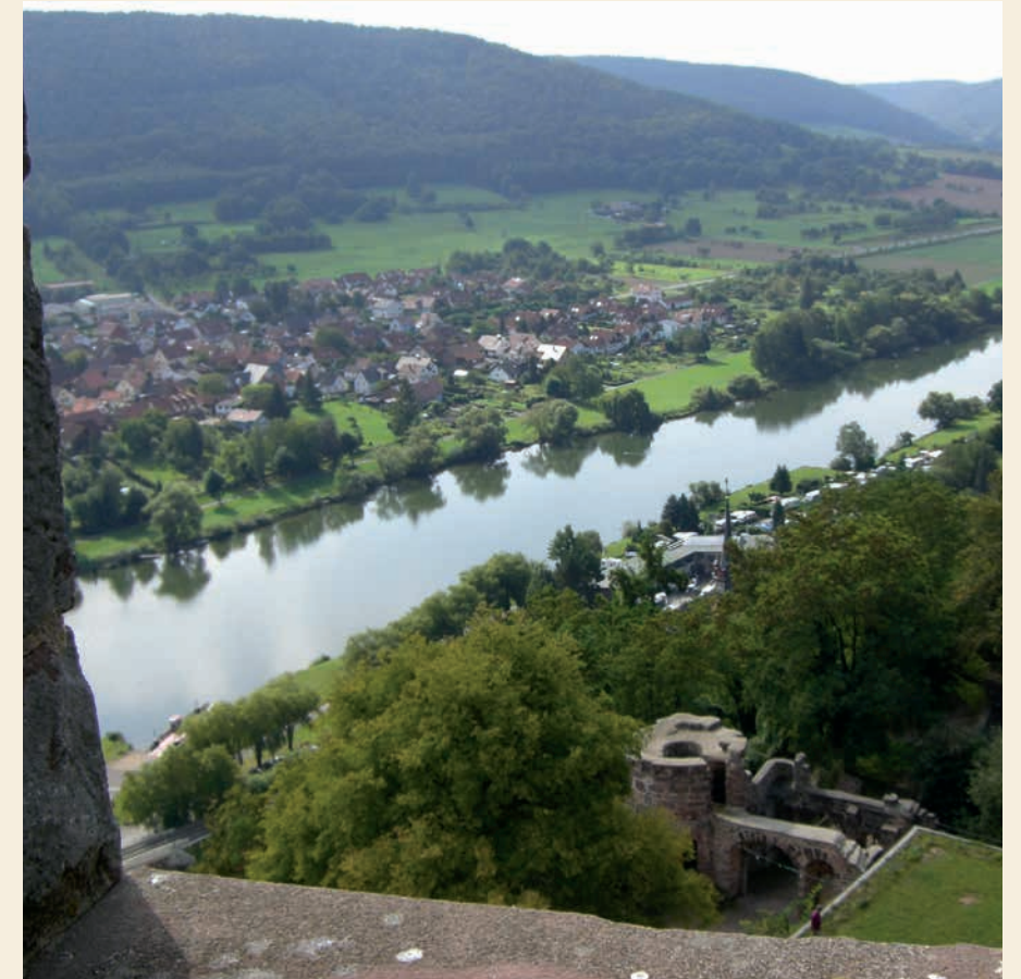
Blick vom jüngeren Bergfried auf Main und Toranlage
