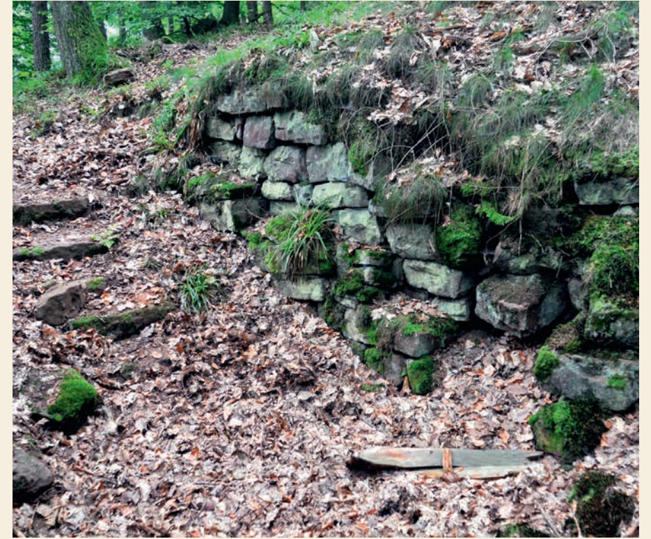
Mauerreste des „Räuberschlosschens“
